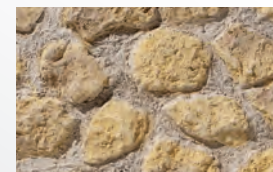
PIEDRA DE ADOBE
